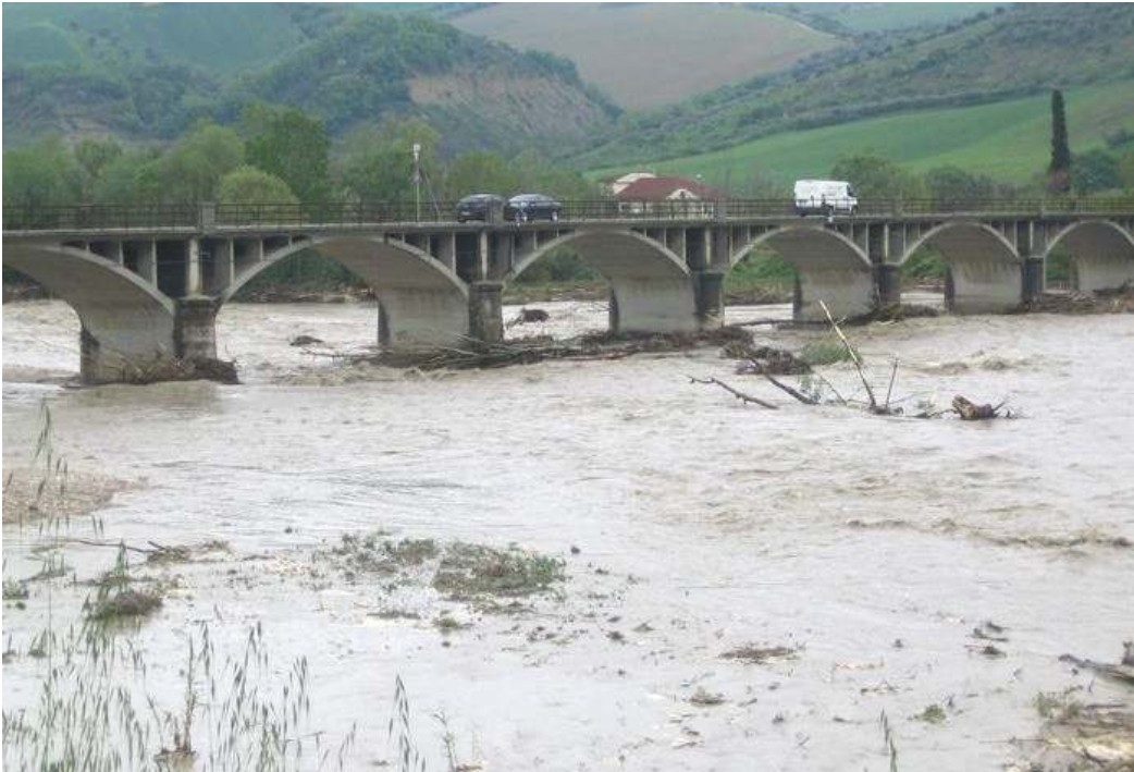
Ponte sul Tronto zona Pagliare(provincia Ascoli Piceno)foto da un giornale locale
