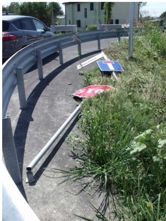
Fig. 6.5 – Cartello stradale abbattuto dal tornado. Foto di Alberto Gobbi.
