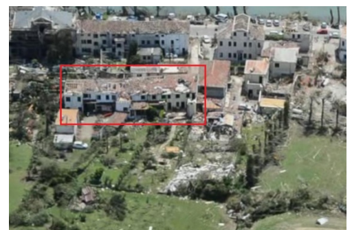
IMMAGINE 2: D.I. DANNEGGIATO O PRIMA DEL DANNO
