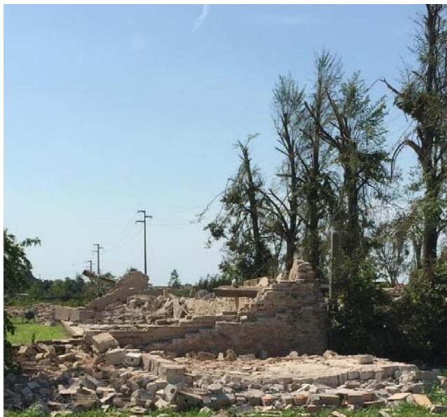
IMMAGINE 1: D.I. DANNEGGIATO
