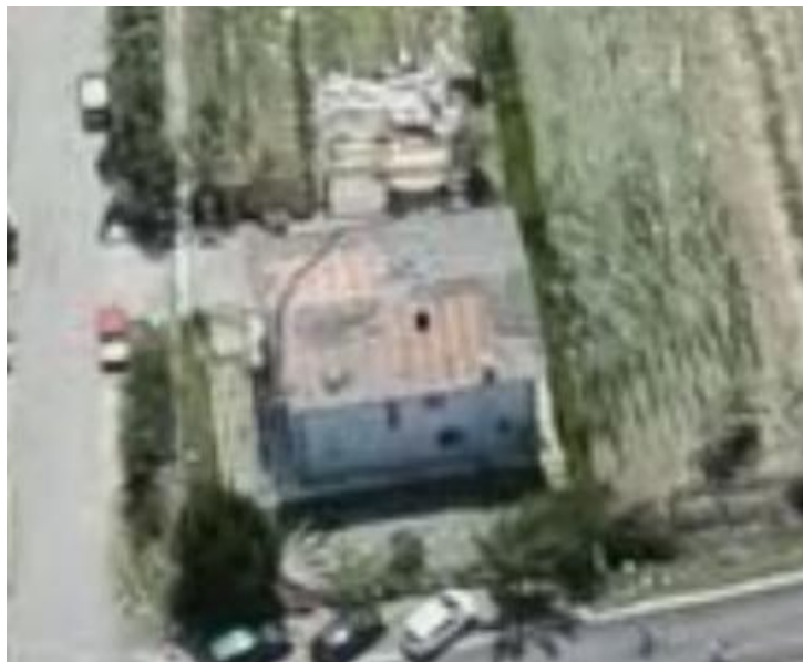
IMMAGINE 1: D.I. DANNEGGIATO
