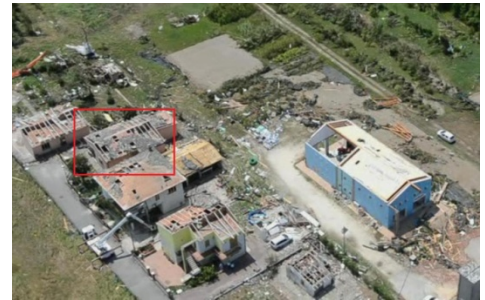
IMMAGINE 2: D.I. DANNEGGIATO O PRIMA DEL DANNO
