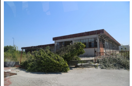
IMMAGINE 2: D.I. DANNEGGIATO O PRIMA DEL DANNO
