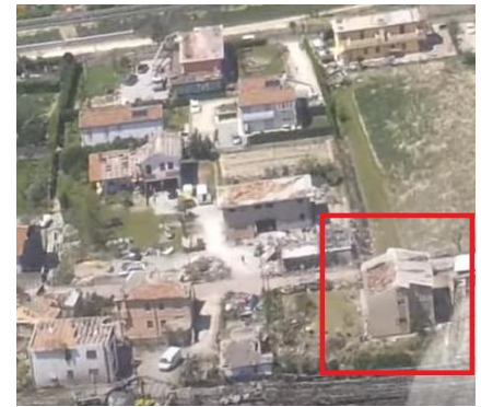
IMMAGINE 2: D.I. DANNEGGIATO O PRIMA DEL DANNO
