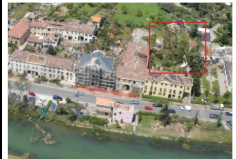
IMMAGINE 2: D.I. DANNEGGIATO O PRIMA DEL DANNO
