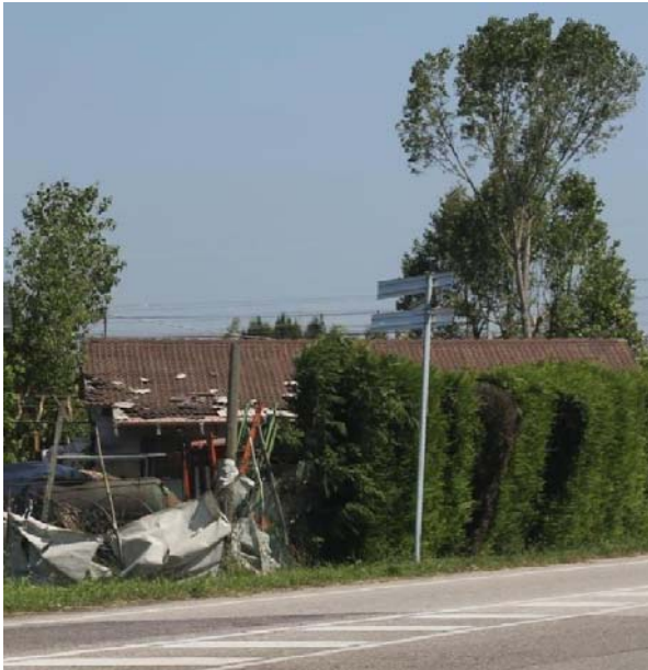
IMMAGINE 1: D.I. DANNEGGIATO
