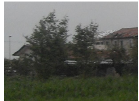
IMMAGINE 2: D.I. DANNEGGIATO O PRIMA DEL DANNO
