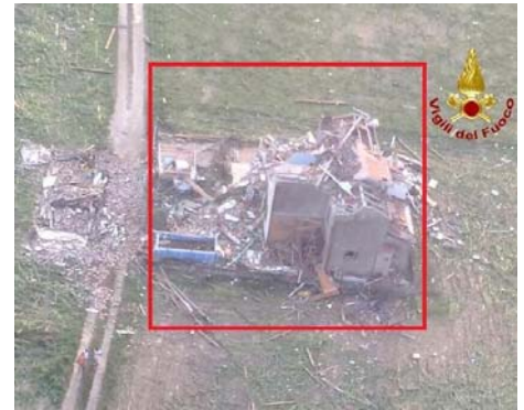
IMMAGINE 2: D.I. DANNEGGIATO O PRIMA DEL DANNO
