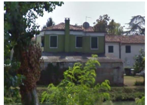
IMMAGINE 2: D.I. DANNEGGIATO O PRIMA DEL DANNO
