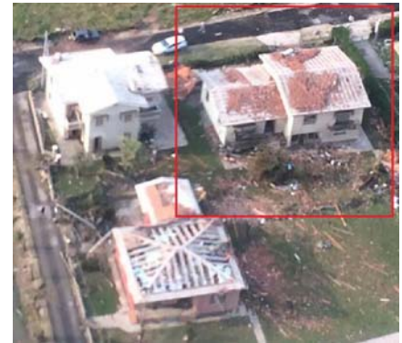
IMMAGINE 2: D.I. DANNEGGIATO O PRIMA DEL DANNO
