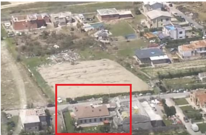
IMMAGINE 1: D.I. DANNEGGIATO
