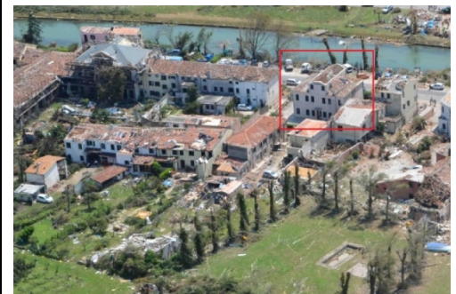
IMMAGINE 2: D.I. DANNEGGIATO O PRIMA DEL DANNO
