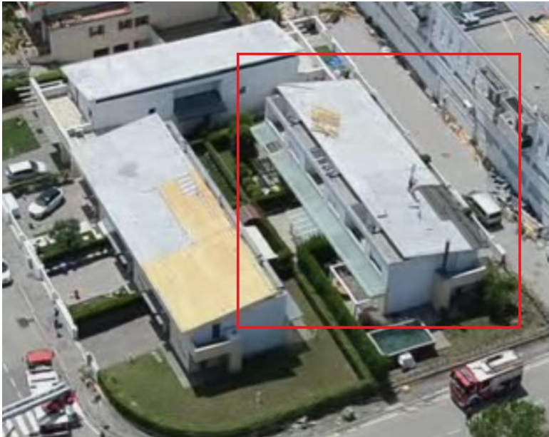
IMMAGINE 1: D.I. DANNEGGIATO
