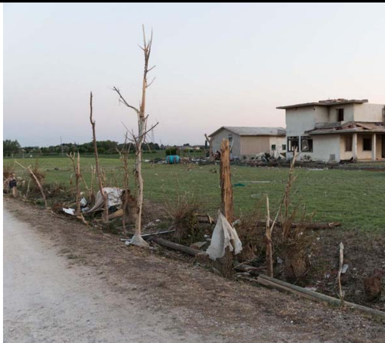
IMMAGINE 1: D.I. DANNEGGIATO
