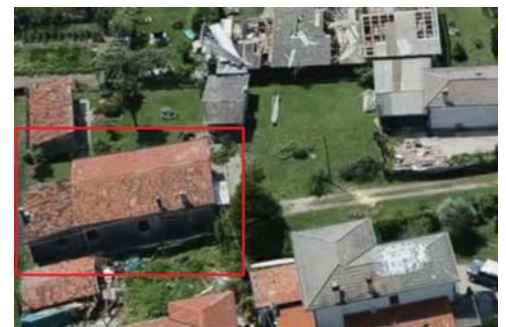
IMMAGINE 2: D.I. DANNEGGIATO O PRIMA DEL DANNO
