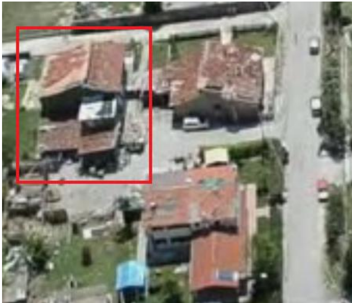
IMMAGINE 1: D.I. DANNEGGIATO
