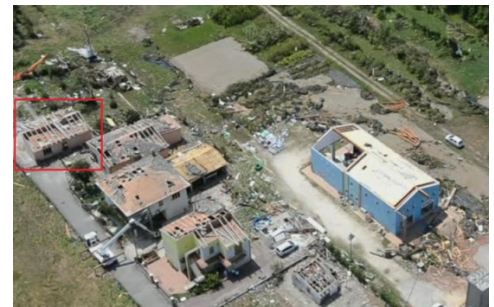
IMMAGINE 2: D.I. DANNEGGIATO O PRIMA DEL DANNO
