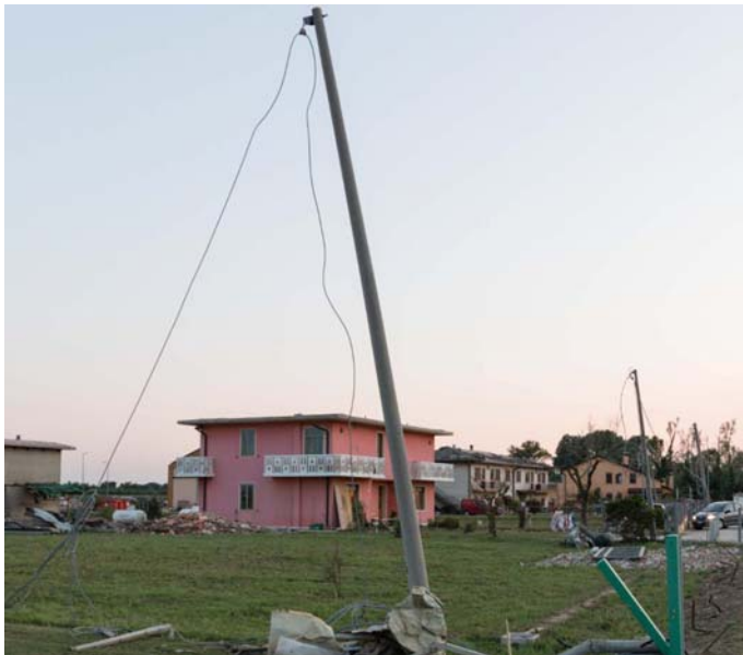
IMMAGINE 1: D.I. DANNEGGIATO
