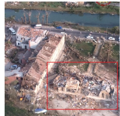
IMMAGINE 2: D.I. DANNEGGIATO O PRIMA DEL DANNO
