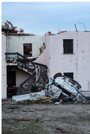
IMMAGINE 5: D.I. DANNEGGIATO
