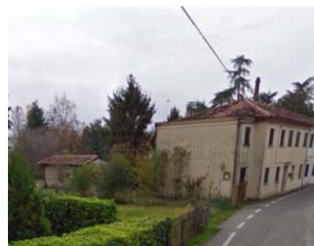
IMMAGINE 2: D.I. DANNEGGIATO O PRIMA DEL DANNO
