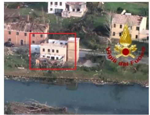
IMMAGINE 2: D.I. DANNEGGIATO O PRIMA DEL DANNO
