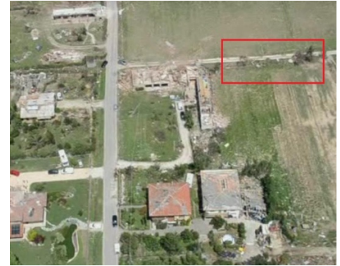
IMMAGINE 2: D.I. DANNEGGIATO O PRIMA DEL DANNO
