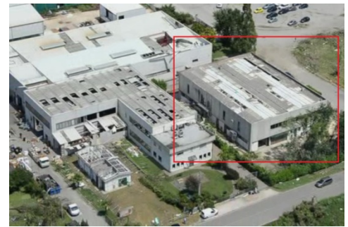
IMMAGINE 2: D.I. DANNEGGIATO O PRIMA DEL DANNO
