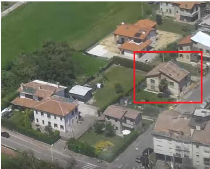
IMMAGINE 1: D.I. DANNEGGIATO
