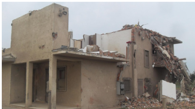
IMMAGINE 6: D.I. DANNEGGIATO
