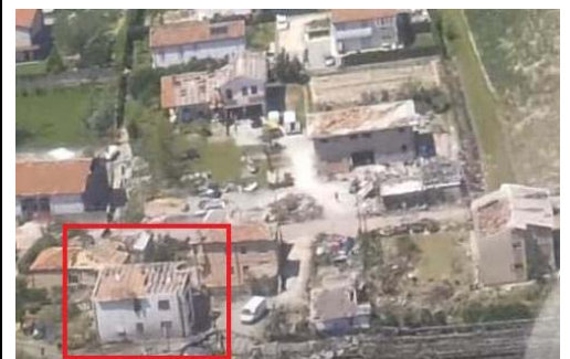
IMMAGINE 2: D.I. DANNEGGIATO O PRIMA DEL DANNO
