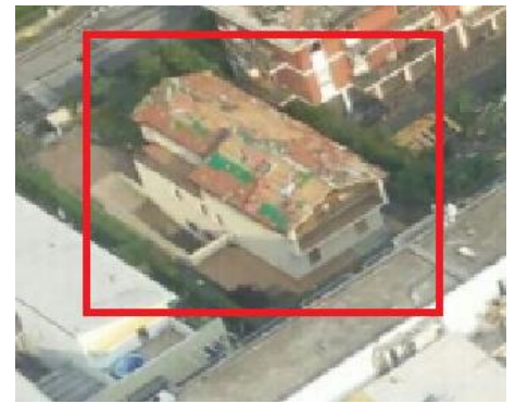
IMMAGINE 2: D.I. DANNEGGIATO O PRIMA DEL DANNO
