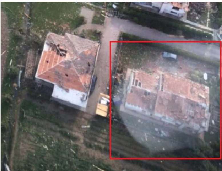
IMMAGINE 1: D.I. DANNEGGIATO
