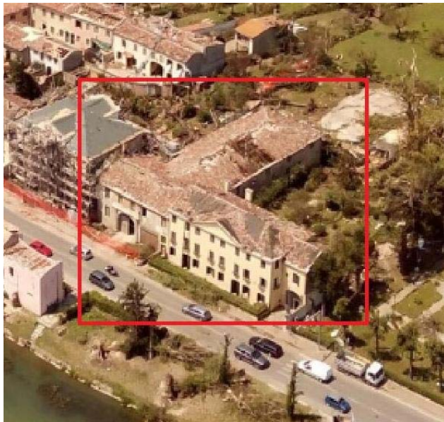
IMMAGINE 1: D.I. DANNEGGIATO
