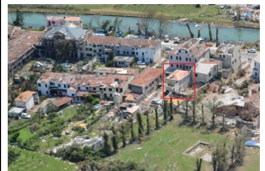
IMMAGINE 2: D.I. DANNEGGIATO O PRIMA DEL DANNO
