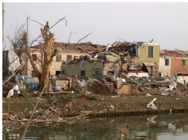
IMMAGINE 5: D.I. DANNEGGIATO
