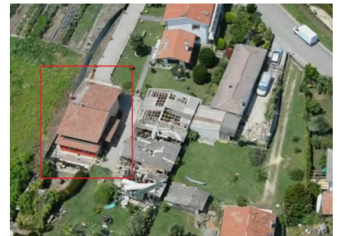
IMMAGINE 2: D.I. DANNEGGIATO O PRIMA DEL DANNO
