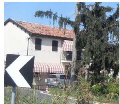
IMMAGINE 2: D.I. DANNEGGIATO O PRIMA DEL DANNO
