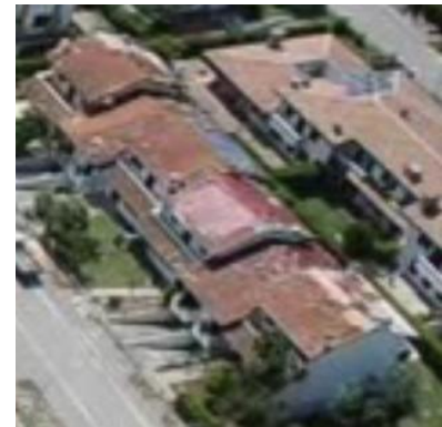
IMMAGINE 2: D.I. DANNEGGIATO O PRIMA DEL DANNO
