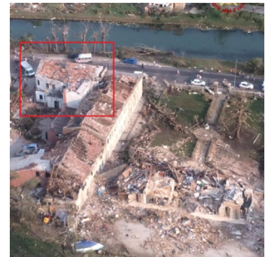
IMMAGINE 2: D.I. DANNEGGIATO O PRIMA DEL DANNO
