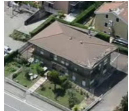
IMMAGINE 2: D.I. DANNEGGIATO O PRIMA DEL DANNO
