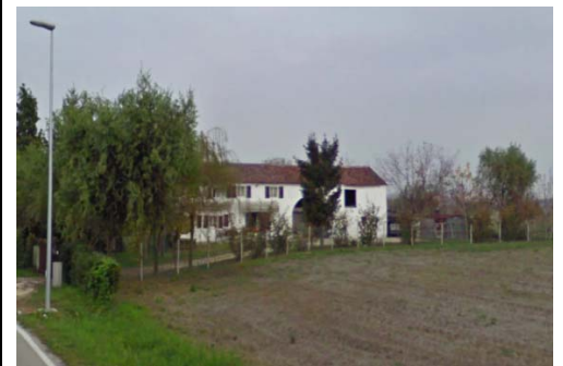
IMMAGINE 2: D.I. DANNEGGIATO O PRIMA DEL DANNO
