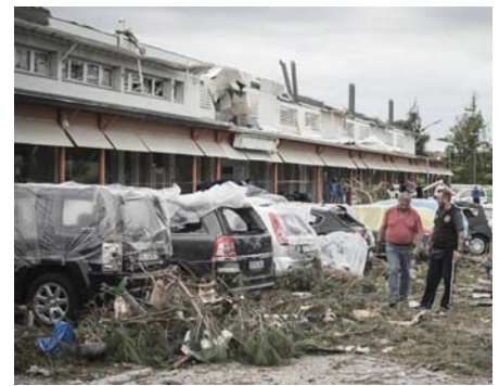
IMMAGINE 2: D.I. DANNEGGIATO O PRIMA DEL DANNO
