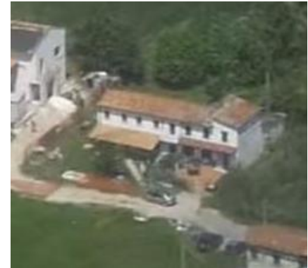
IMMAGINE 2: D.I. DANNEGGIATO O PRIMA DEL DANNO
