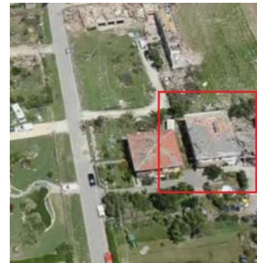
IMMAGINE 2: D.I. DANNEGGIATO O PRIMA DEL DANNO
