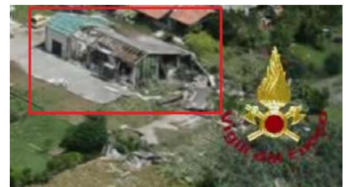
IMMAGINE 2: D.I. DANNEGGIATO O PRIMA DEL DANNO
