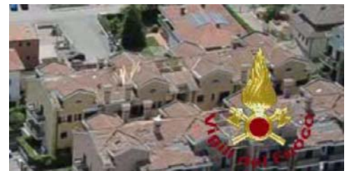
IMMAGINE 2: D.I. DANNEGGIATO O PRIMA DEL DANNO
