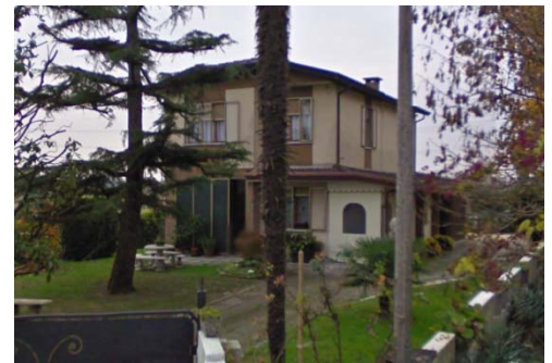
IMMAGINE 2: D.I. DANNEGGIATO O PRIMA DEL DANNO
