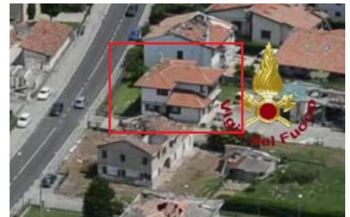
IMMAGINE 2: D.I. DANNEGGIATO O PRIMA DEL DANNO
