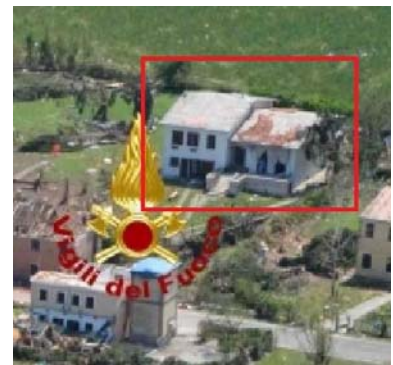
IMMAGINE 2: D.I. DANNEGGIATO O PRIMA DEL DANNO
