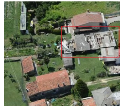
IMMAGINE 2: D.I. DANNEGGIATO O PRIMA DEL DANNO
