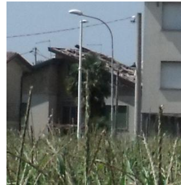
IMMAGINE 2: D.I. DANNEGGIATO O PRIMA DEL DANNO
