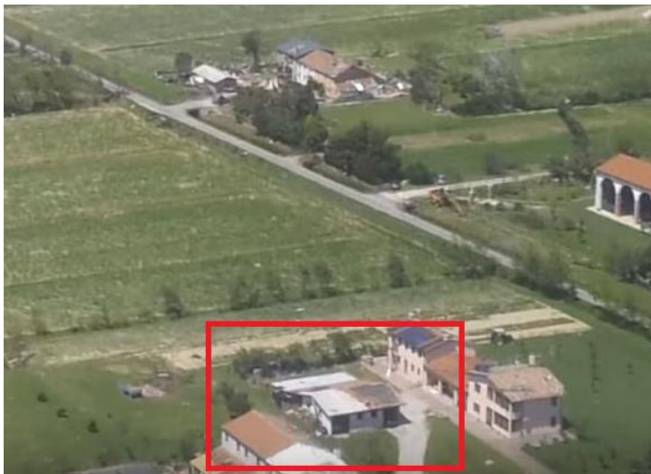
IMMAGINE 1: D.I. DANNEGGIATO
