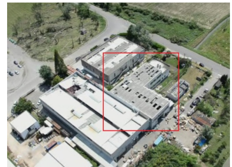
IMMAGINE 2: D.I. DANNEGGIATO O PRIMA DEL DANNO
