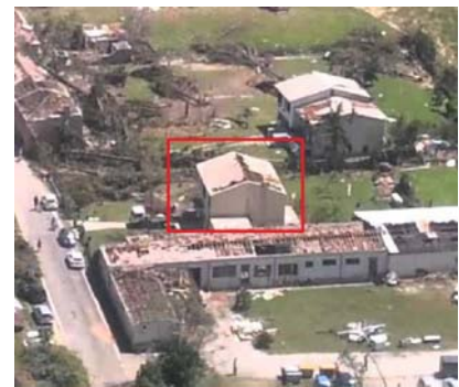
IMMAGINE 2: D.I. DANNEGGIATO O PRIMA DEL DANNO
