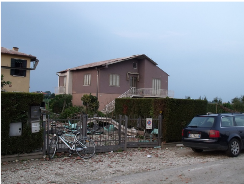
IMMAGINE 1: D.I. DANNEGGIATO
