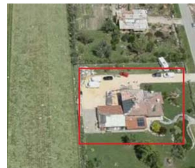
IMMAGINE 2: D.I. DANNEGGIATO O PRIMA DEL DANNO
