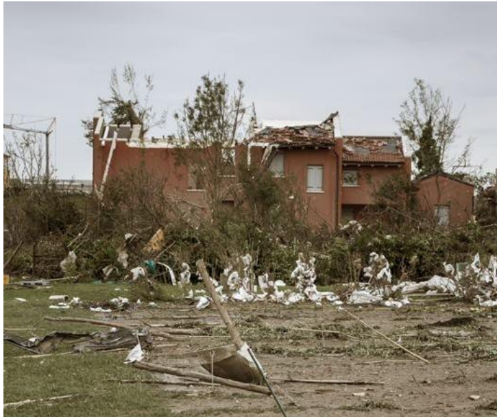
IMMAGINE 1: D.I. DANNEGGIATO
