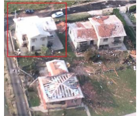
IMMAGINE 2: D.I. DANNEGGIATO O PRIMA DEL DANNO
