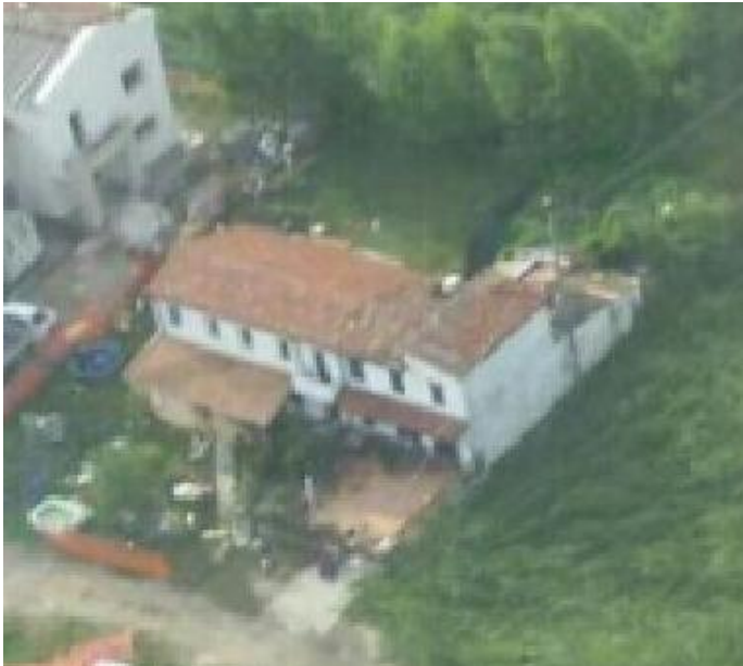
IMMAGINE 1: D.I. DANNEGGIATO
