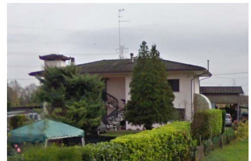
IMMAGINE 2: D.I. DANNEGGIATO O PRIMA DEL DANNO
