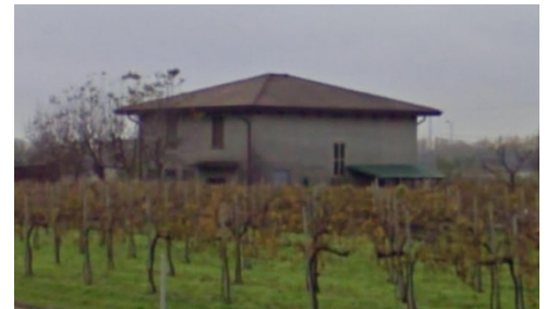
IMMAGINE 2: D.I. DANNEGGIATO O PRIMA DEL DANNO
