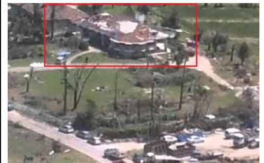
IMMAGINE 2: D.I. DANNEGGIATO O PRIMA DEL DANNO
