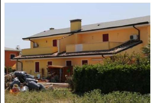
IMMAGINE 2: D.I. DANNEGGIATO O PRIMA DEL DANNO
