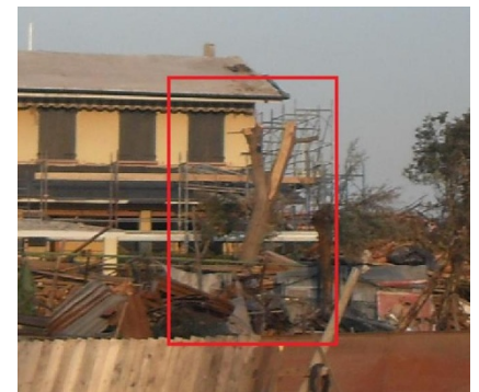
IMMAGINE 2: D.I. DANNEGGIATO O PRIMA DEL DANNO
