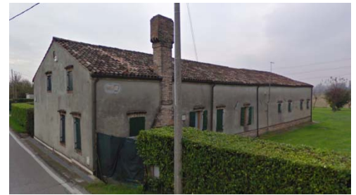
IMMAGINE 2: D.I. DANNEGGIATO O PRIMA DEL DANNO
