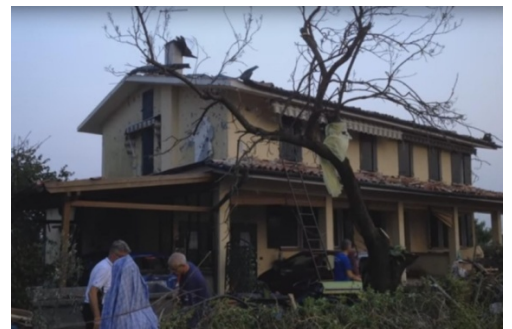
IMMAGINE 2: D.I. DANNEGGIATO O PRIMA DEL DANNO
