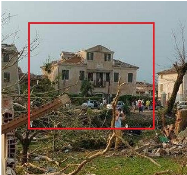
IMMAGINE 1: D.I. DANNEGGIATO
