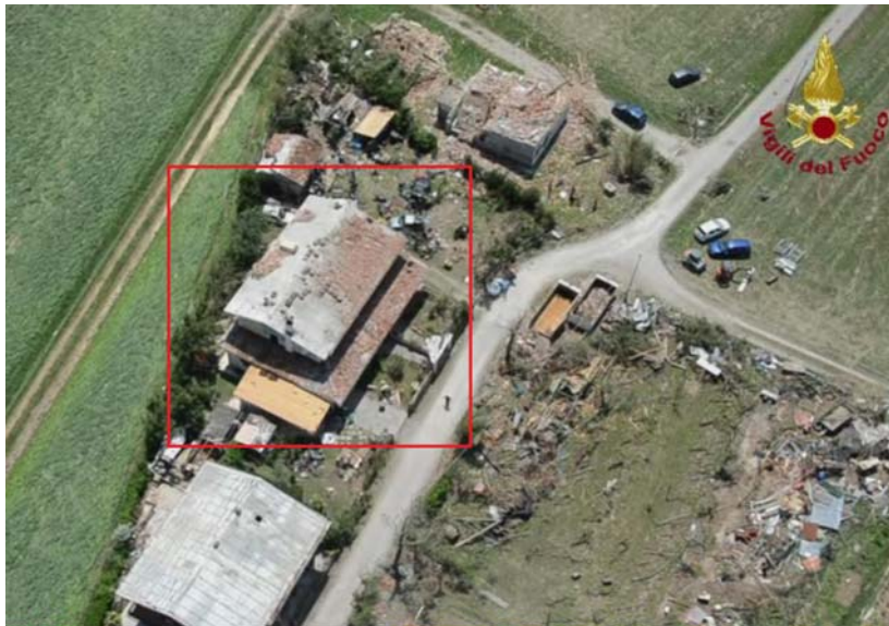
IMMAGINE 1: D.I. DANNEGGIATO
