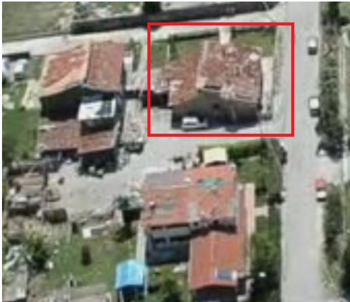
IMMAGINE 1: D.I. DANNEGGIATO
