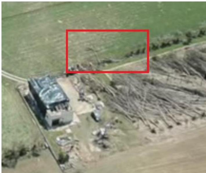
IMMAGINE 1: D.I. DANNEGGIATO
