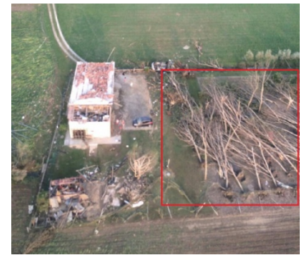
IMMAGINE 2: D.I. DANNEGGIATO O PRIMA DEL DANNO
