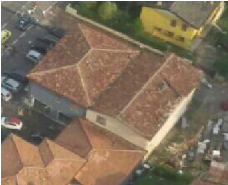
IMMAGINE 1: D.I. DANNEGGIATO
