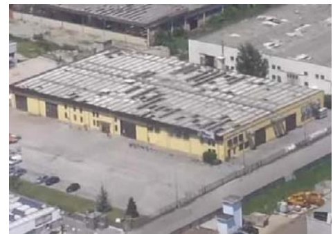
IMMAGINE 2: D.I. DANNEGGIATO O PRIMA DEL DANNO
