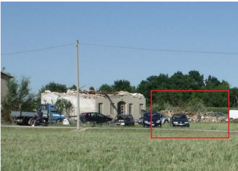
IMMAGINE 1: D.I. DANNEGGIATO
