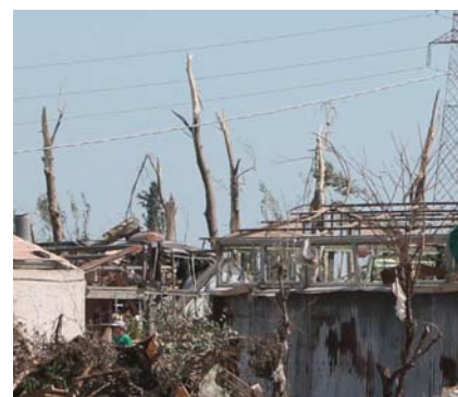
IMMAGINE 2: D.I. DANNEGGIATO O PRIMA DEL DANNO
