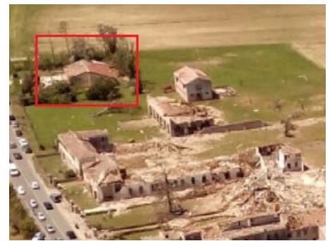
IMMAGINE 2: D.I. DANNEGGIATO O PRIMA DEL DANNO
