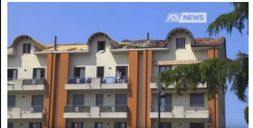
IMMAGINE 2: D.I. DANNEGGIATO O PRIMA DEL DANNO
