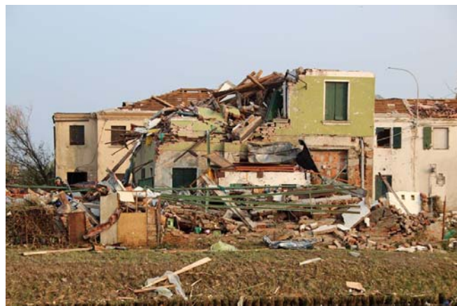
IMMAGINE 6: D.I. DANNEGGIATO
