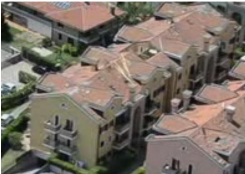
IMMAGINE 1: D.I. DANNEGGIATO
