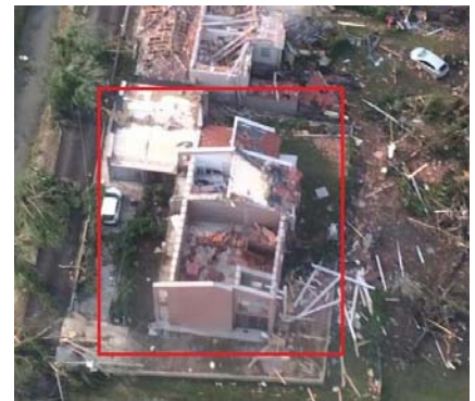
IMMAGINE 2: D.I. DANNEGGIATO O PRIMA DEL DANNO
