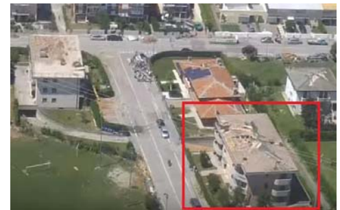
IMMAGINE 2: D.I. DANNEGGIATO O PRIMA DEL DANNO
