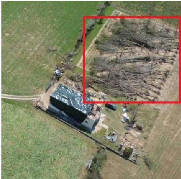
IMMAGINE 1: D.I. DANNEGGIATO
