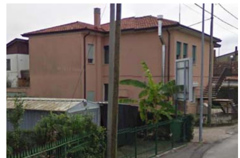
IMMAGINE 2: D.I. DANNEGGIATO O PRIMA DEL DANNO
