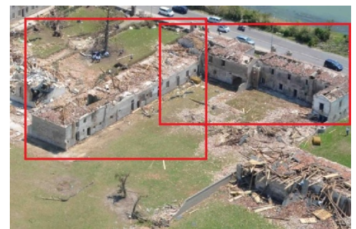
IMMAGINE 2: D.I. DANNEGGIATO O PRIMA DEL DANNO
