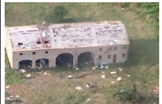
IMMAGINE 2: D.I. DANNEGGIATO O PRIMA DEL DANNO
