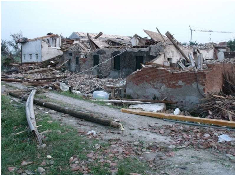
IMMAGINE 1: D.I. DANNEGGIATO
