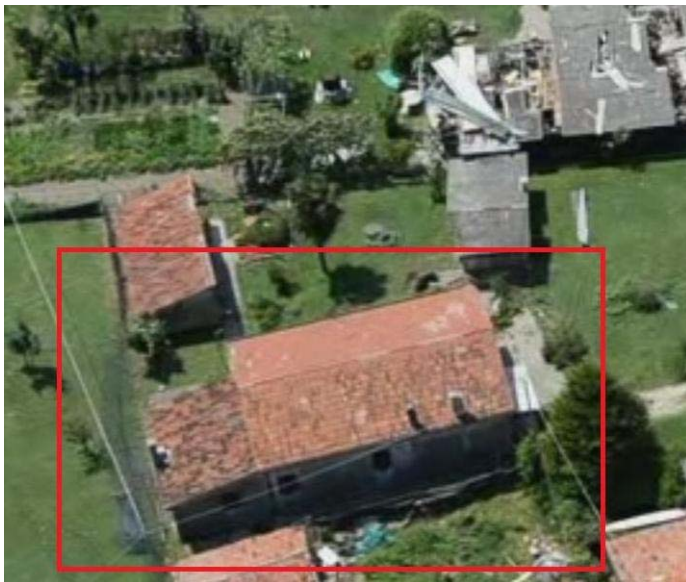
IMMAGINE 1: D.I. DANNEGGIATO
