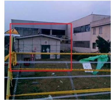
IMMAGINE 2: D.I. DANNEGGIATO O PRIMA DEL DANNO
