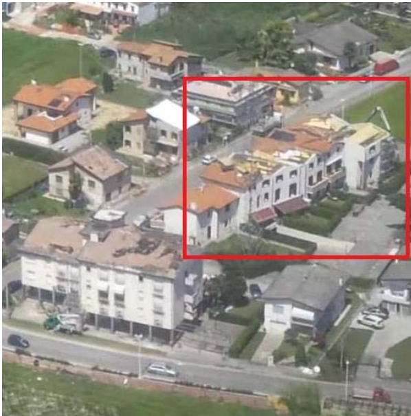
IMMAGINE 1: D.I. DANNEGGIATO
