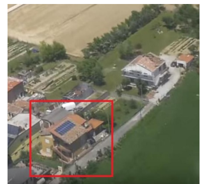
IMMAGINE 2: D.I. DANNEGGIATO O PRIMA DEL DANNO
