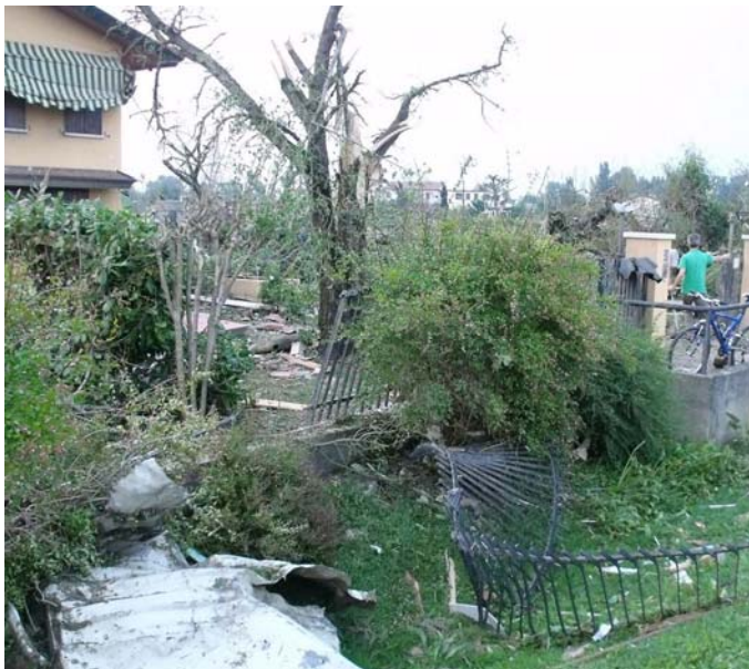
IMMAGINE 1: D.I. DANNEGGIATO
