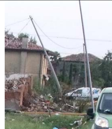
IMMAGINE 2: D.I. DANNEGGIATO O PRIMA DEL DANNO
