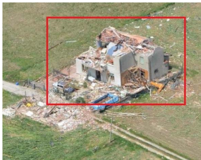
IMMAGINE 4: D.I. DANNEGGIATO
