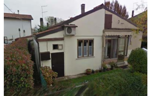
IMMAGINE 2: D.I. DANNEGGIATO O PRIMA DEL DANNO
