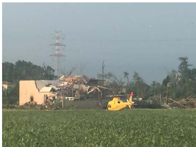
IMMAGINE 3: D.I. DANNEGGIATO
