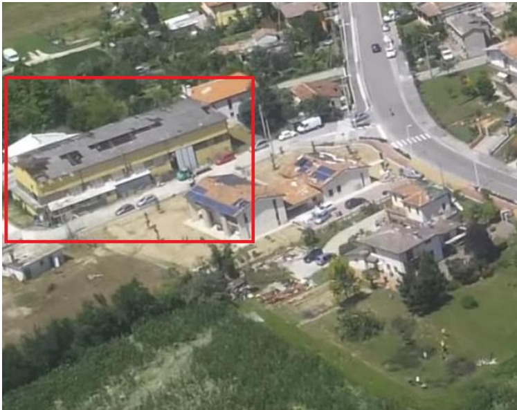
IMMAGINE 1: D.I. DANNEGGIATO
