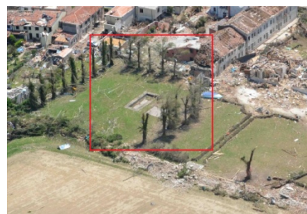
IMMAGINE 2: D.I. DANNEGGIATO O PRIMA DEL DANNO
