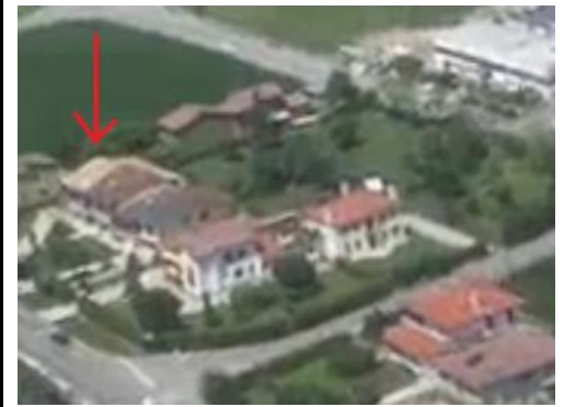
IMMAGINE 2: D.I. DANNEGGIATO O PRIMA DEL DANNO
