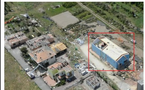
IMMAGINE 2: D.I. DANNEGGIATO O PRIMA DEL DANNO
