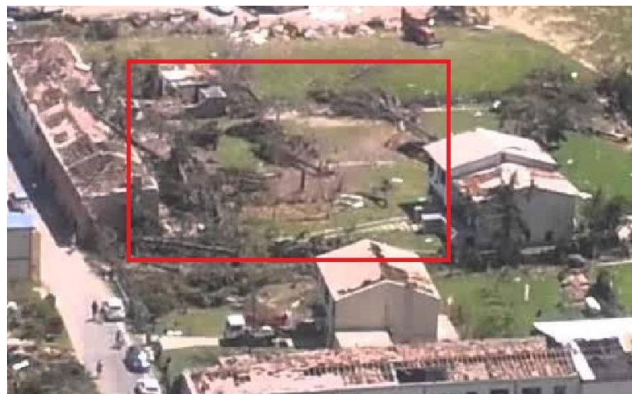
IMMAGINE 1: D.I. DANNEGGIATO
