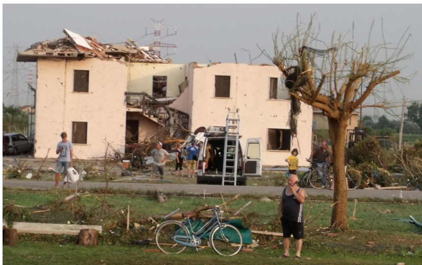
IMMAGINE 1: D.I. DANNEGGIATO
