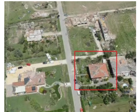
IMMAGINE 2: D.I. DANNEGGIATO O PRIMA DEL DANNO
