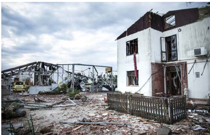
IMMAGINE 1: N.D.I. DANNEGGIATO
