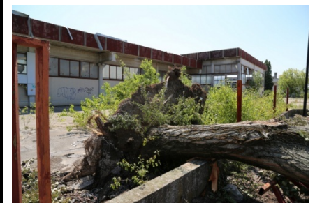
IMMAGINE 2: D.I. DANNEGGIATO O PRIMA DEL DANNO
