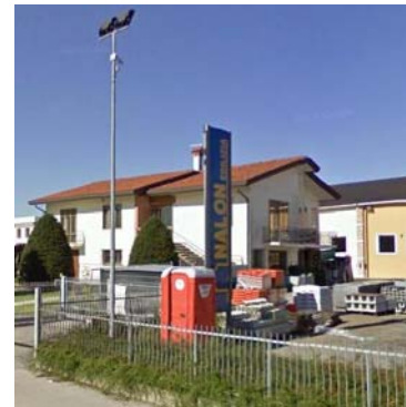
IMMAGINE 2: D.I. DANNEGGIATO O PRIMA DEL DANNO
