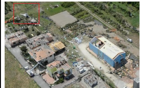
IMMAGINE 2: D.I. DANNEGGIATO O PRIMA DEL DANNO
