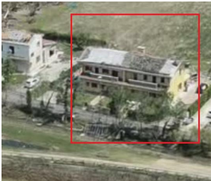
IMMAGINE 1: D.I. DANNEGGIATO
