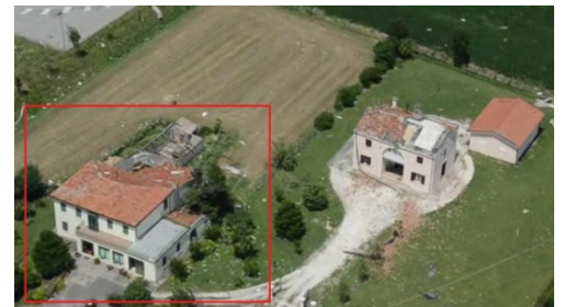
IMMAGINE 2: D.I. DANNEGGIATO O PRIMA DEL DANNO
