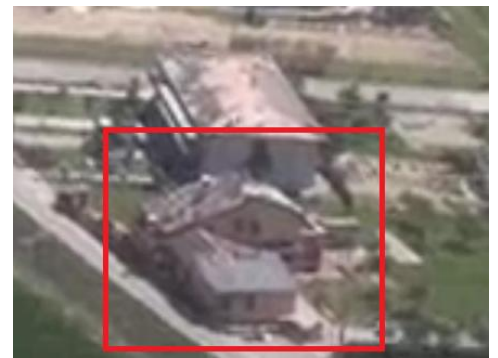
IMMAGINE 2: D.I. DANNEGGIATO O PRIMA DEL DANNO
