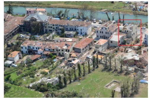
IMMAGINE 2: D.I. DANNEGGIATO O PRIMA DEL DANNO
