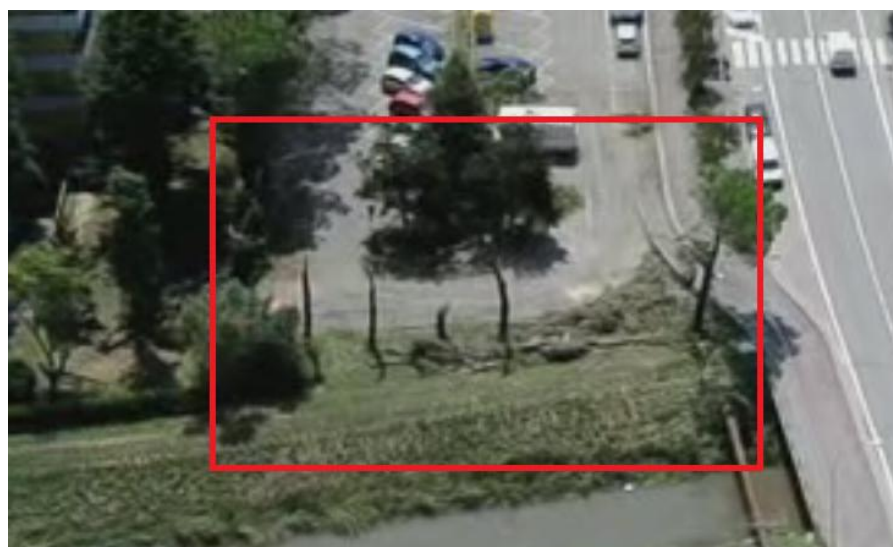
IMMAGINE 1: D.I. DANNEGGIATO
