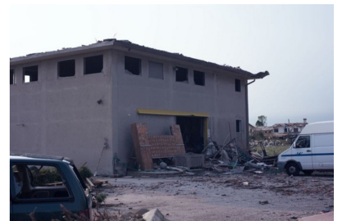
IMMAGINE 2: D.I. DANNEGGIATO O PRIMA DEL DANNO
