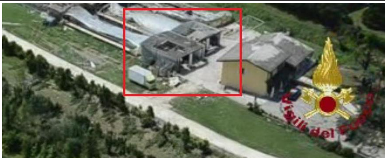
IMMAGINE 1: N.D.I. DANNEGGIATO
