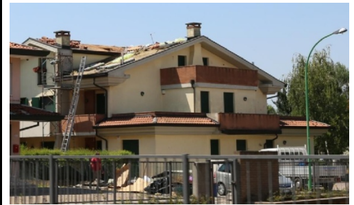
IMMAGINE 2: D.I. DANNEGGIATO O PRIMA DEL DANNO
