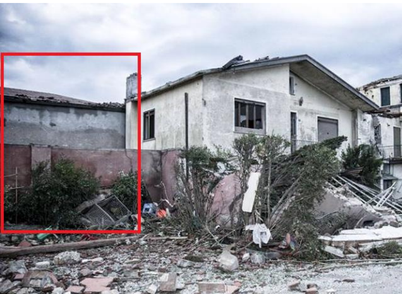
IMMAGINE 1: D.I. DANNEGGIATO
