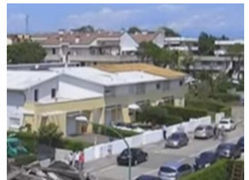
IMMAGINE 2: D.I. DANNEGGIATO O PRIMA DEL DANNO
