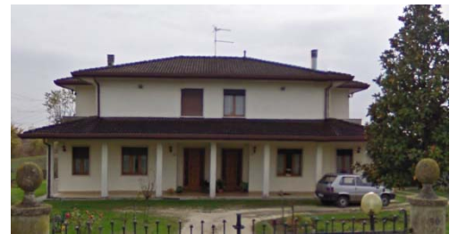
IMMAGINE 2: D.I. DANNEGGIATO O PRIMA DEL DANNO
