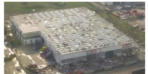
IMMAGINE 2: D.I. DANNEGGIATO O PRIMA DEL DANNO
