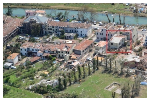
IMMAGINE 2: D.I. DANNEGGIATO O PRIMA DEL DANNO
