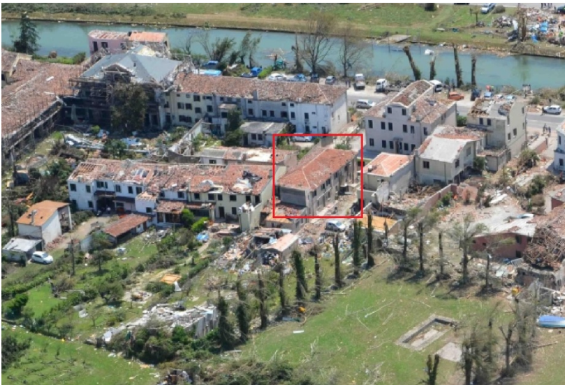
IMMAGINE 1: D.I. DANNEGGIATO
