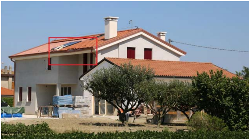
IMMAGINE 1: D.I. DANNEGGIATO
