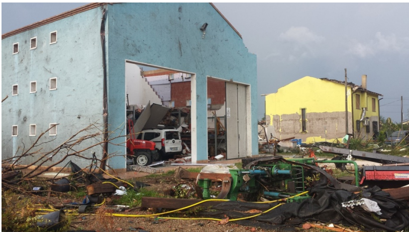
IMMAGINE 1: D.I. DANNEGGIATO
