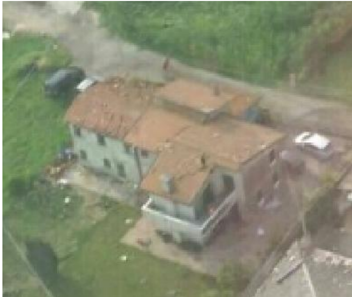
IMMAGINE 1: D.I. DANNEGGIATO
