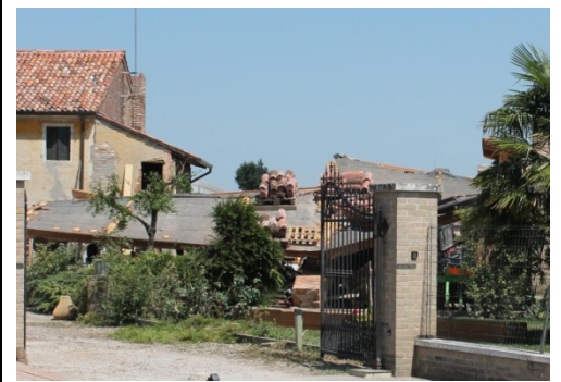
IMMAGINE 2: D.I. DANNEGGIATO O PRIMA DEL DANNO
