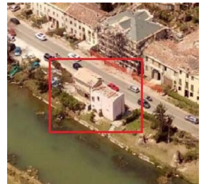
IMMAGINE 2: D.I. DANNEGGIATO O PRIMA DEL DANNO
