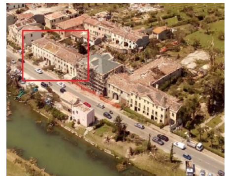
IMMAGINE 2: D.I. DANNEGGIATO O PRIMA DEL DANNO
