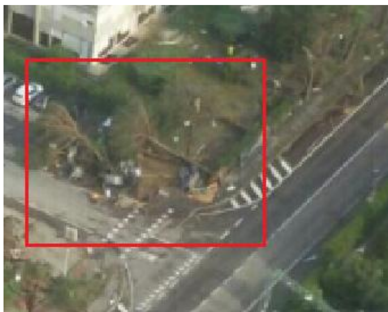
IMMAGINE 1: D.I. DANNEGGIATO
