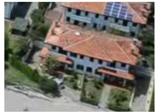
IMMAGINE 2: D.I. DANNEGGIATO O PRIMA DEL DANNO
