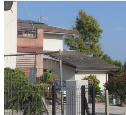
IMMAGINE 2: D.I. DANNEGGIATO O PRIMA DEL DANNO
