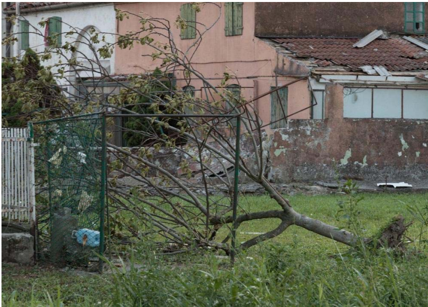
IMMAGINE 1: D.I. DANNEGGIATO
