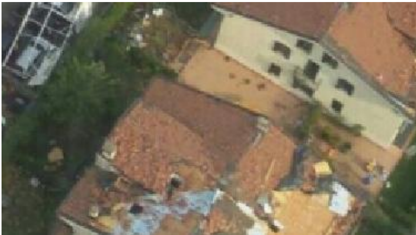
IMMAGINE 1: D.I. DANNEGGIATO
