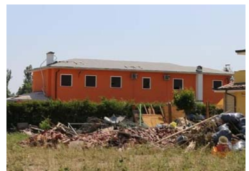
IMMAGINE 2: D.I. DANNEGGIATO O PRIMA DEL DANNO
