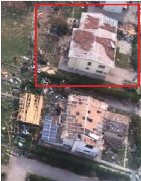
IMMAGINE 1: D.I. DANNEGGIATO
