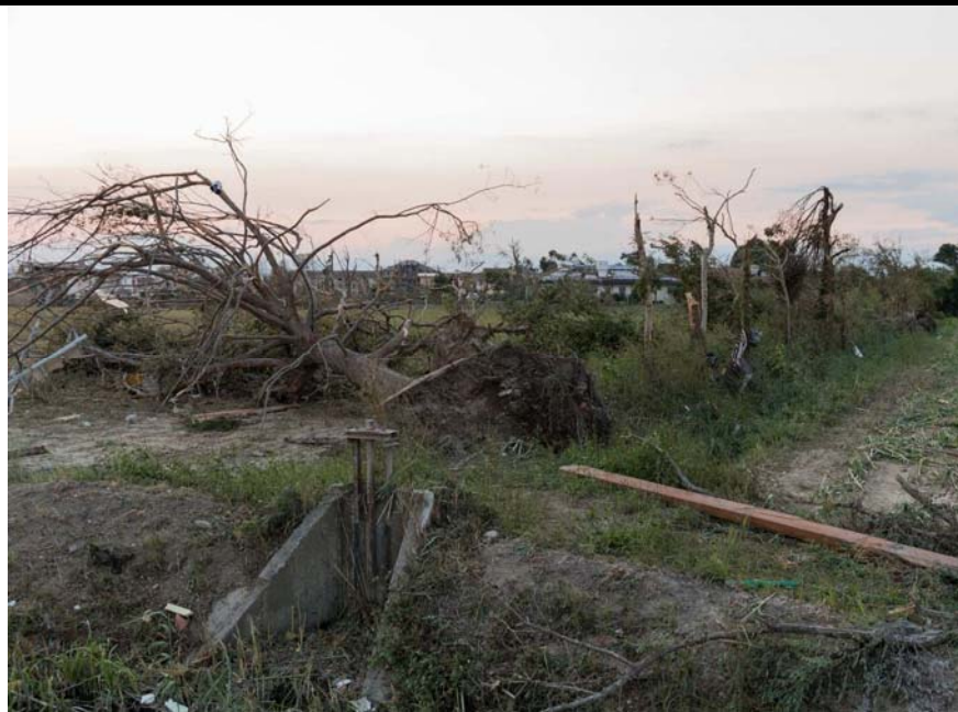
IMMAGINE 1: D.I. DANNEGGIATO
