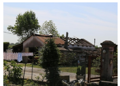
IMMAGINE 2: D.I. DANNEGGIATO O PRIMA DEL DANNO
