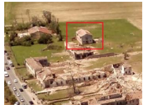
IMMAGINE 2: D.I. DANNEGGIATO O PRIMA DEL DANNO
