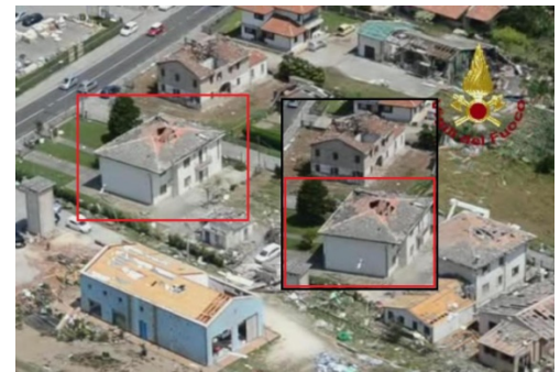
IMMAGINE 2: D.I. DANNEGGIATO O PRIMA DEL DANNO
