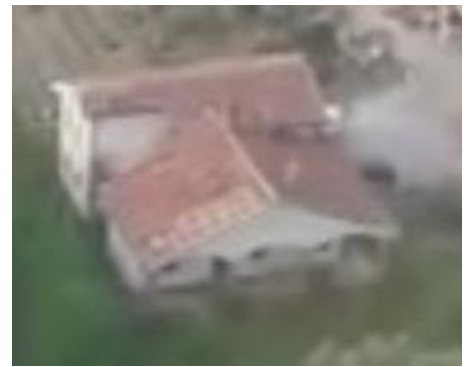
IMMAGINE 2: D.I. DANNEGGIATO O PRIMA DEL DANNO
