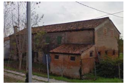
IMMAGINE 2: D.I. DANNEGGIATO O PRIMA DEL DANNO
