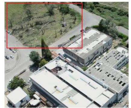
IMMAGINE 2: D.I. DANNEGGIATO O PRIMA DEL DANNO
