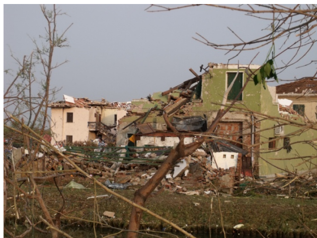
IMMAGINE 4: D.I. DANNEGGIATO
