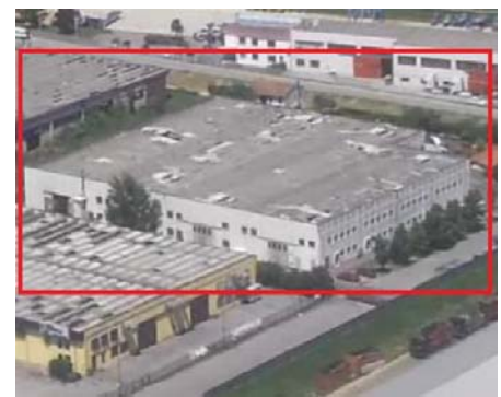
IMMAGINE 2: D.I. DANNEGGIATO O PRIMA DEL DANNO
