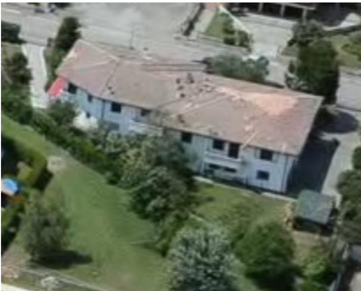
IMMAGINE 1: D.I. DANNEGGIATO
