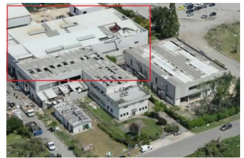
IMMAGINE 2: D.I. DANNEGGIATO O PRIMA DEL DANNO
