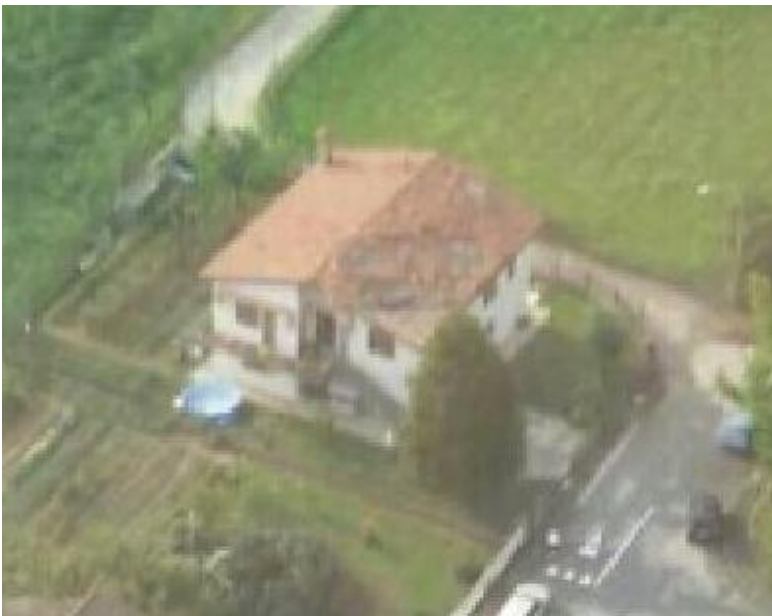
IMMAGINE 1: D.I. DANNEGGIATO
