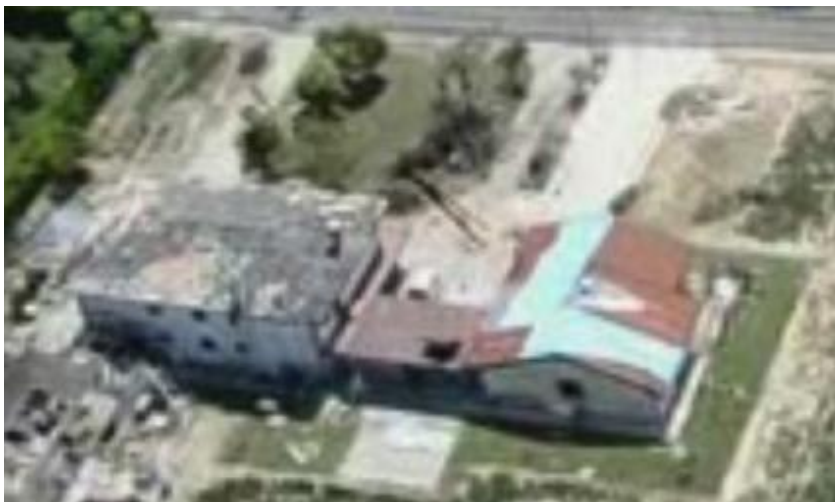
IMMAGINE 1: D.I. DANNEGGIATO
