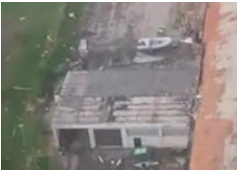
IMMAGINE 1: D.I. DANNEGGIATO
