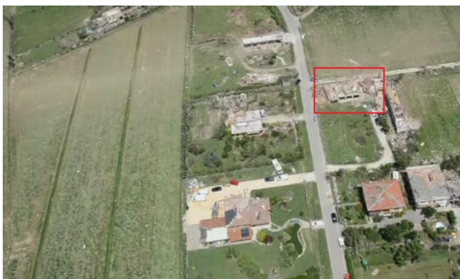
IMMAGINE 7: D.I. DANNEGGIATO
