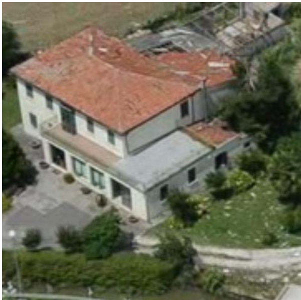
IMMAGINE 1: D.I. DANNEGGIATO
