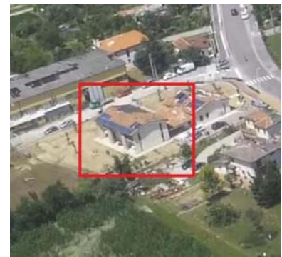
IMMAGINE 2: D.I. DANNEGGIATO O PRIMA DEL DANNO
