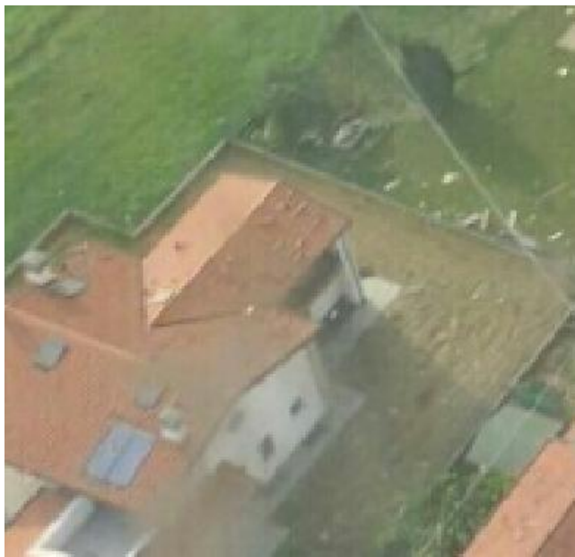
IMMAGINE 1: D.I. DANNEGGIATO
