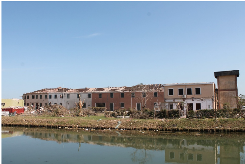
IMMAGINE 1: D.I. DANNEGGIATO
