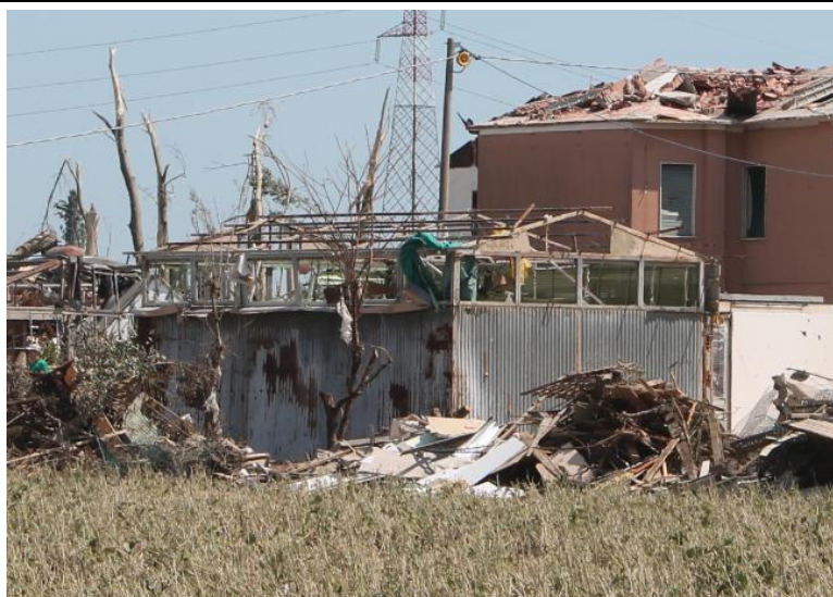
IMMAGINE 1: N.D.I. DANNEGGIATO
