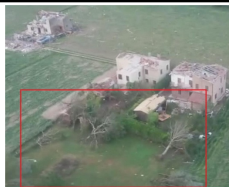
IMMAGINE 2: D.I. DANNEGGIATO O PRIMA DEL DANNO
