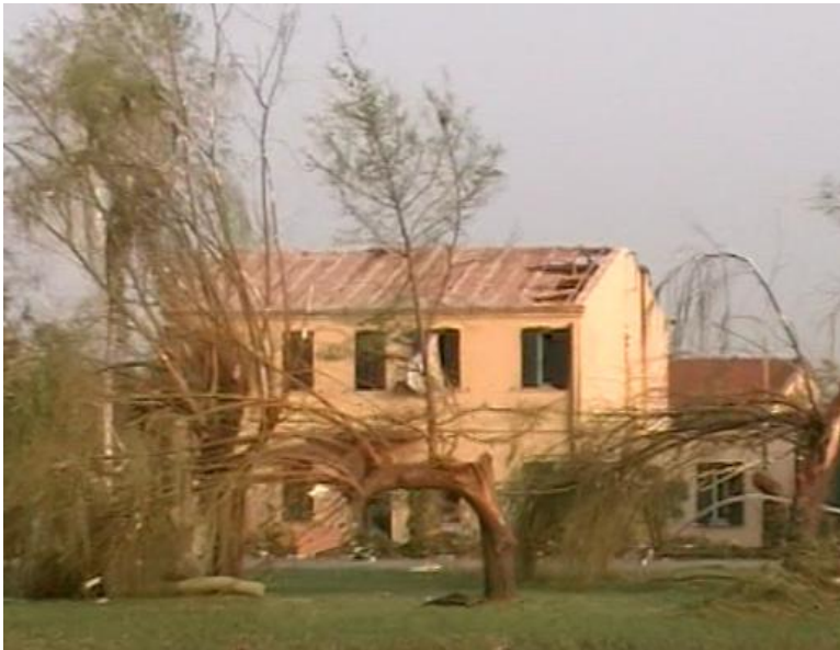
IMMAGINE 1: D.I. DANNEGGIATO
