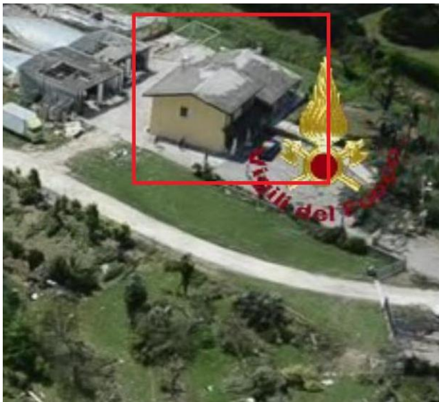
IMMAGINE 1: D.I. DANNEGGIATO
