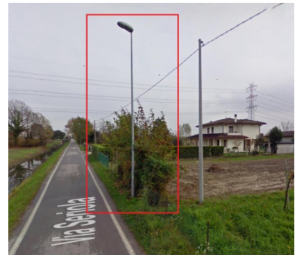
IMMAGINE 2: D.I. DANNEGGIATO O PRIMA DEL DANNO
