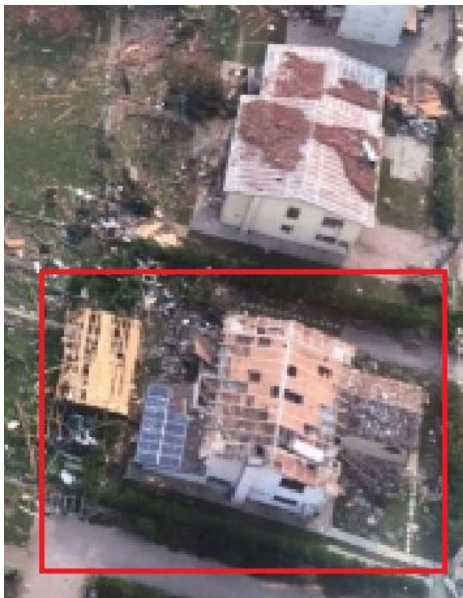
IMMAGINE 1: D.I. DANNEGGIATO
