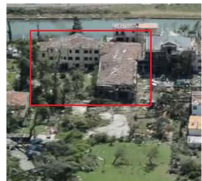
IMMAGINE 2: D.I. DANNEGGIATO O PRIMA DEL DANNO
