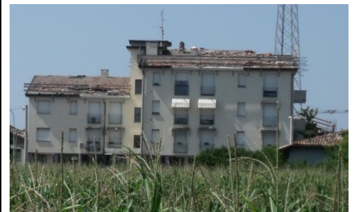
IMMAGINE 2: D.I. DANNEGGIATO O PRIMA DEL DANNO
