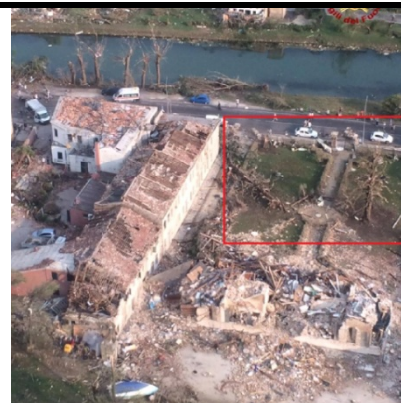
IMMAGINE 2: D.I. DANNEGGIATO O PRIMA DEL DANNO
