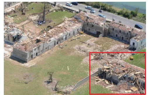
IMMAGINE 2: D.I. DANNEGGIATO O PRIMA DEL DANNO
