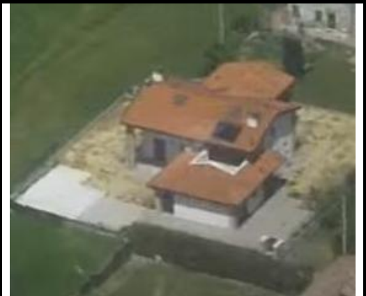
IMMAGINE 2: D.I. DANNEGGIATO O PRIMA DEL DANNO
