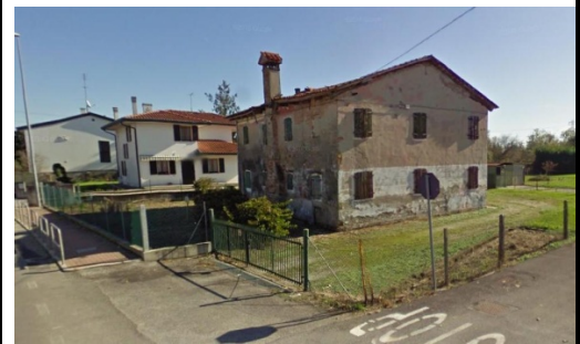
IMMAGINE 2: D.I. DANNEGGIATO O PRIMA DEL DANNO
