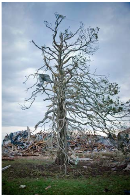
IMMAGINE 1: D.I. DANNEGGIATO
