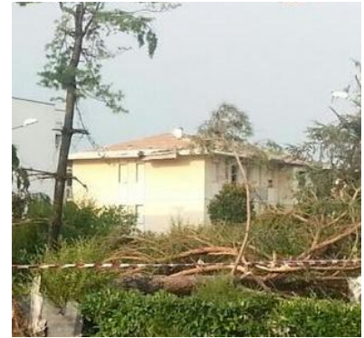
IMMAGINE 2: D.I. DANNEGGIATO O PRIMA DEL DANNO
