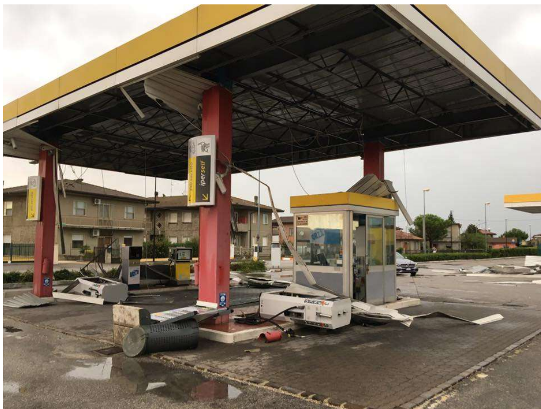
Fig. 5.84 – Danni al distributore di Mezzogoro (FE). Foto di Massimo Biolcati.
