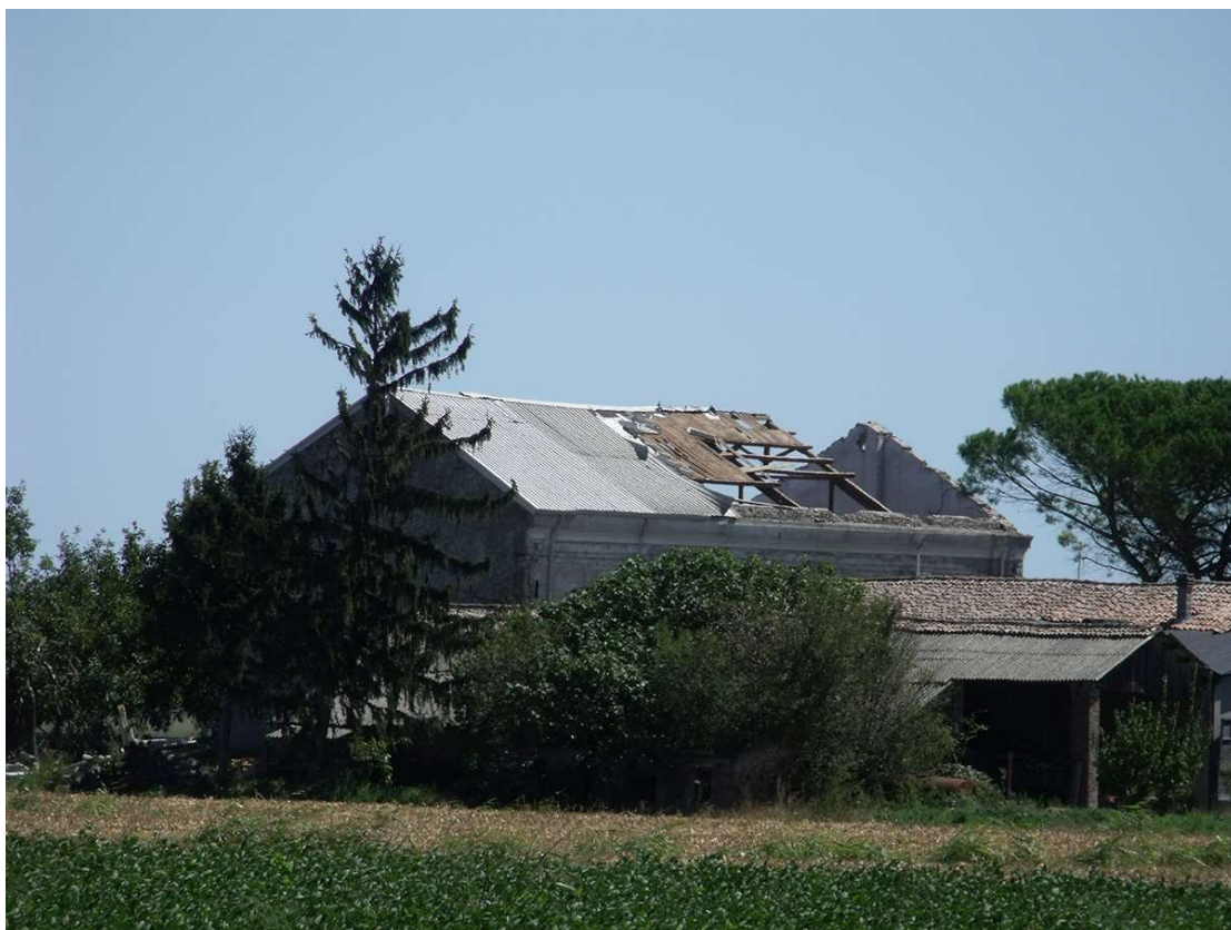
Fig. 5.89 – Danni a Ariano Polesine (RO). Foto di Alberto Gobbi.
