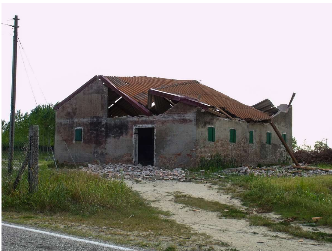
Fig. 5.90 – Danni a Taglio di Po (RO). Foto di Alberto Gobbi.
