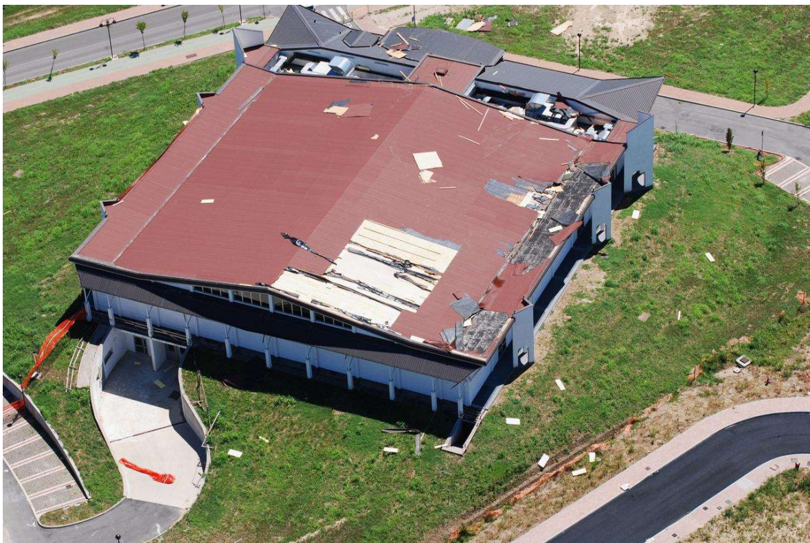
Fig. 5.30 – Danni al palazzetto dello sport di Montegrotto Terme (PD) sul lato sopravvento del tetto rivolto verso ovest, cioè verso la direzione di provenienza delle raffiche lineari associate al downburst.
