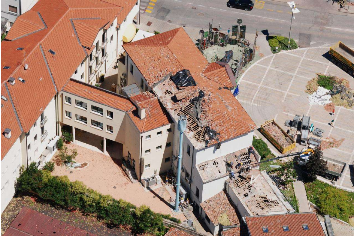
Fig. 5.29 – Danni al municipio di Montegrotto Terme (PD) sul lato sopravvento del tetto rivolto verso ovest, cioè verso la direzione di provenienza delle raffiche lineari associate al downburst.
