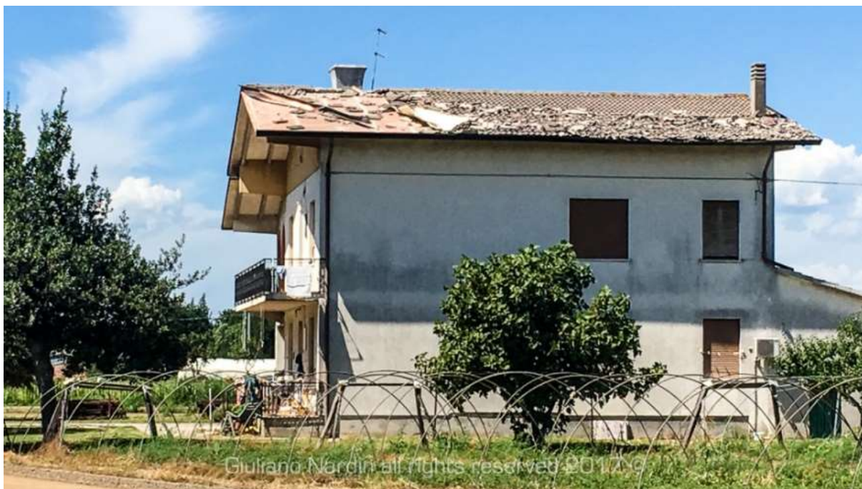
Fig. 5.121 – Danni a Cavallino-Treporti (VE). Foto di Giuliano Nardin.
