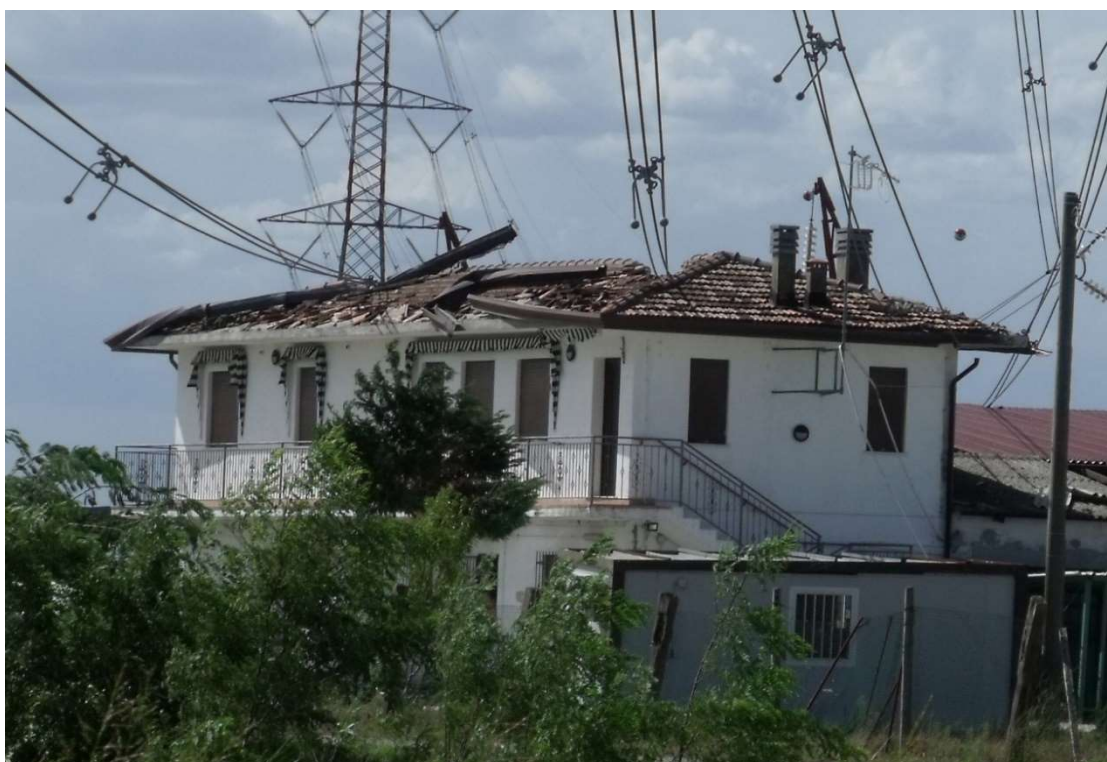
Fig. 5.88 – Danni a Taglio di Po (RO). Foto di Alberto Gobbi.
