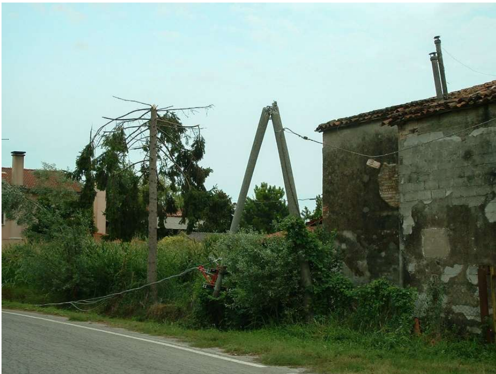
Fig. 5.19 – Palo in cemento a Campolongo Maggiore (VE) spezzato da un “burst swath”. Foto di Alberto Gobbi.
